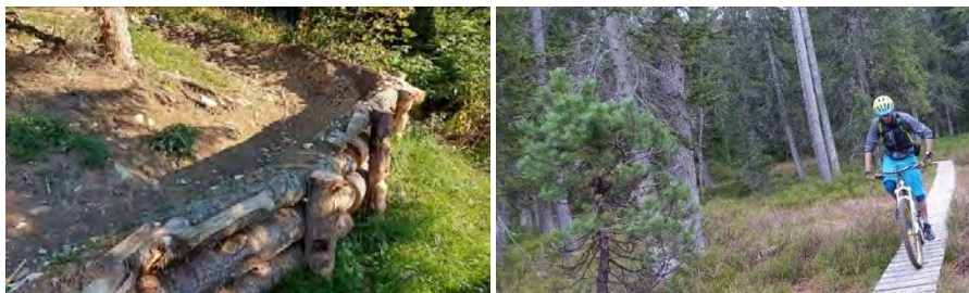
Figure 5. Exemple d'une stabilisation bien intégrée d'une piste VTT à Leysin et d'une passerelle permettant de canaliser les VTT au niveau de la traversée d'une zone marécageuse (la tourbière - Pointe de Puvat - Les Glières)
