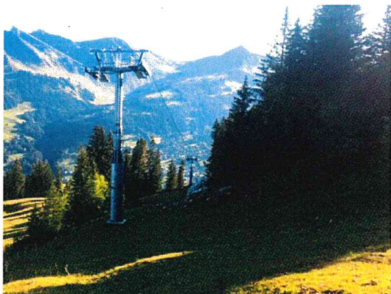
Figure 1 : zones 1 et 2 terrassées à défricher et zone 3 (emprise du pylône) conforme en l'état (1.9.21).
